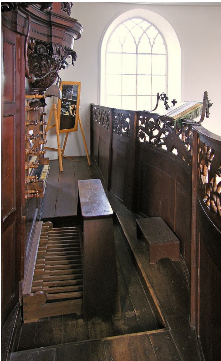
Foto uit 2007 met het in 1931 verlaagde vloergedeelte. Het pedaalklavier is door Reil bij de 1 e fase restauratie in 1987 nieuw aangebracht en naar Freytag gekopieerd.
